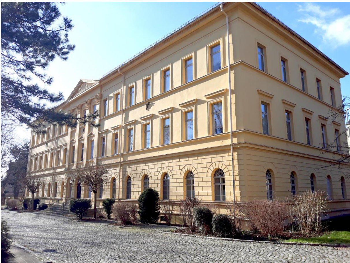
Ansicht Hauptfassade Ostseite
