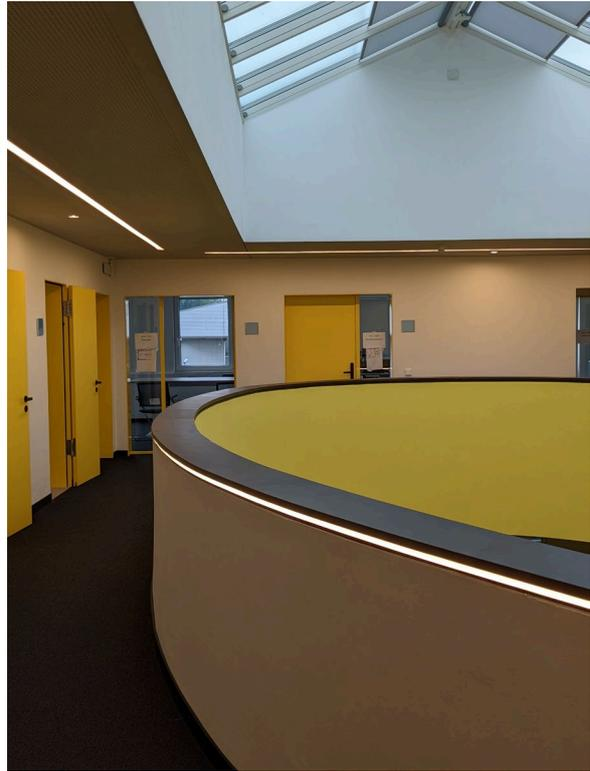
Detail: integriertes Lichtband in Brüstung
