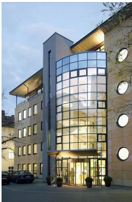
Blick vom Innenhof
