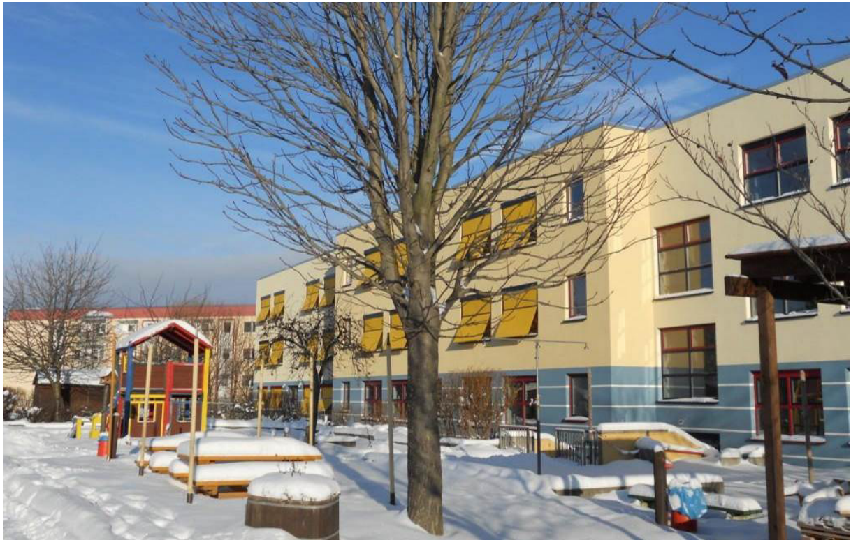
Südfassade mit Sonnenschutz
