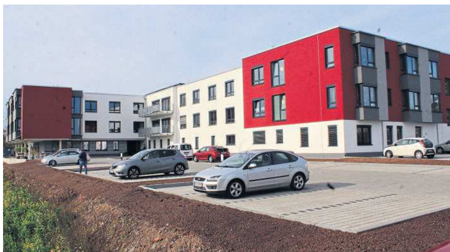
Die gesamte Außenanlage der neuen DRK-Senioren- und Pflegeeinrichtung wurde vom Galabau Koch gestaltet. Die Außenputzarbeiten, teils im Vollwärme-Verbundsystem, sowie den Fassadenanstrich führte die Firma Thomas Weber als weiterer heimischer Handwerksbetrieb aus.
